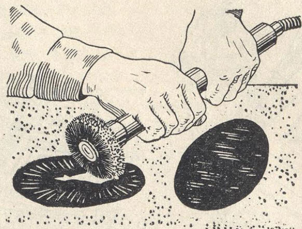
Рис. 39. Шероховка ремонтируемого места с нерабочей стороны ленты.
